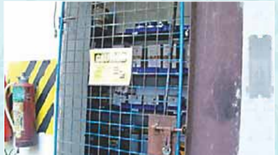
Chemical Storage Area- Caution Signage, Fire Extinguisher Nearby இரசாயணச் சேமிப்புப் பகுதி - எச்சரிக்கை விளம்பரம், தீயணைப்பான் அருகில்
